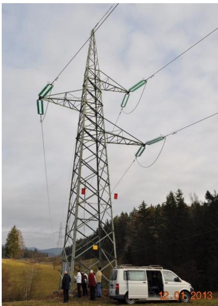
Slika 4.1. Dalekovodni stub na kome su izvršena ispitivanja
