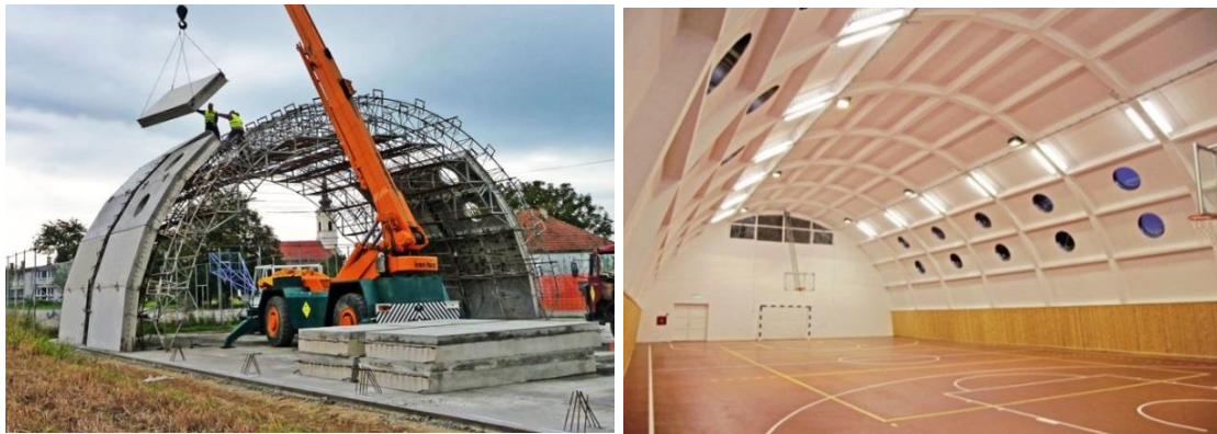
Слика 120. Грађење хале у МС систему градње. [Преузето са http://www.milinkovicco.com/preuzimanje_fajlova/slike/hale/izgradnja/7.jpg , 4.11.2012.]
