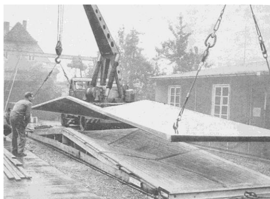
Слика 89. Наборана фероцементна љуска, вађење из калупа. [Извор: Н. Rile, Prostorne krovne kostrukcije (Beograd: Građevinska knjiga, 1977), 234]
