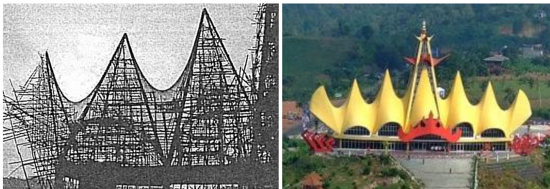
Слика 124. Хиперболичне фероцементне љуске у фази градње, Менара Сигер, Лампунг, Индонезија, постављање скелетне и мрежне арматуре. [Извор: А. Djausal and Bauzoni, „Two stages of construction of Menara Siger ferrocement structure“, in Ferro-9 - Proceeding of the 9 th International Symposium on Ferrocement and Thin Reinforced Cement Composites: Green Technology for Housing and Infrastructure Construction , ed. А. Djausal, F. Alami, and А. Е. Naaman (Bandar Lampung: The University of Lampung, 2009), 465]
