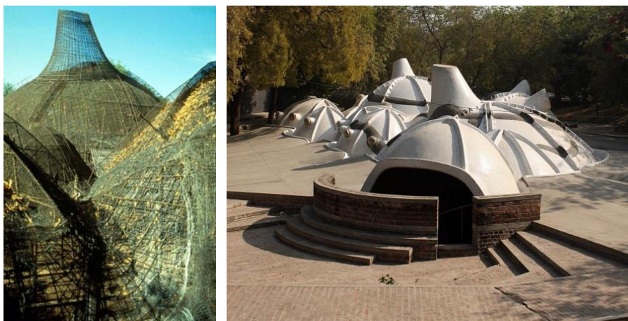
Слика 95. Б.В. Доши, Хусеин Доши Гуфа, Ахмедабад, Индија, 1993., изградња, фасада. [Преузето са http://www.arq.ufsc.br/arq5661/trabalhos_2003-2/argamassa_armada/obras_5.htm и http://en.wikipedia.org/wiki/File:Amdavad_ni_gufa.jpg , 5.6.2012.]
