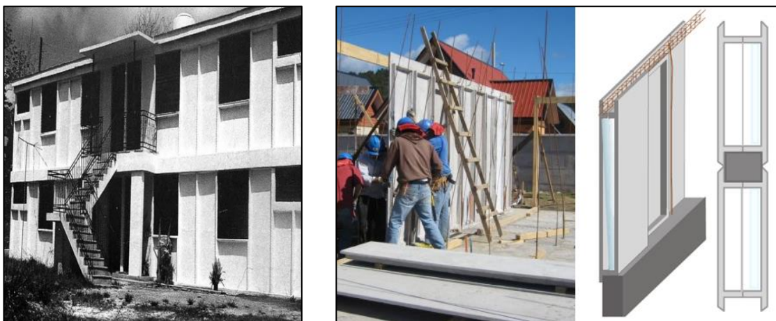
Слика 75. Стамбена зграда изведена применом фероцементних префабрикованих панела, Куба. [Преузето са http://www.asocem.org.pe/web/_actual_int/Cuba.pdf , 8.1.2013.]
