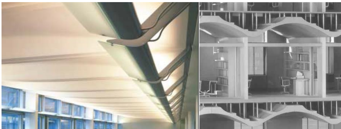
Слика 9. Унутрашњи елементи који рефлектују светлост на глатке површине засвођене бетонске таванице, у оквиру зграде Градског већа; Свордс, Ирска, 2000., архитектонско решење Бухолц МекЕвој архитекти. [Извор: Irish Energy Centre. Fingal county hall - low energy offices, Good Practice Case Study 9. ]
