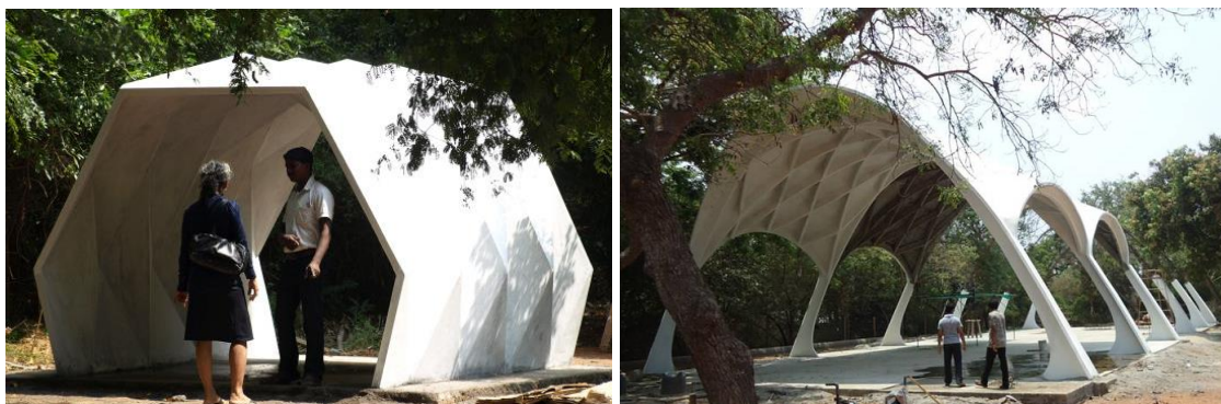
Слика 65. Анупама Кунду, фероцементна наборана структура - прототип „Light Matters“, Индија, 2013. [Преузето са http://cusp-design.com/designer/anupama-kundoo/ , 12.3.2012.]
